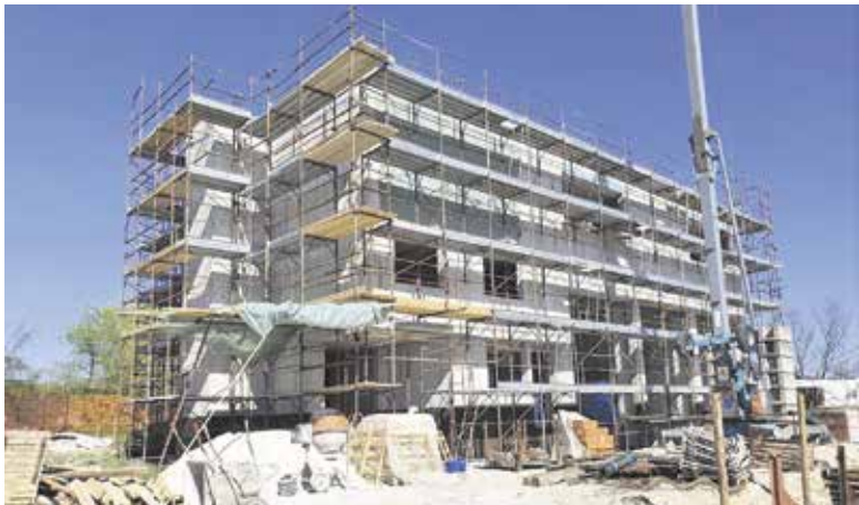
V gradnji je Dom krajanov Študa, ki bo tudi energetska varčna stavba.
